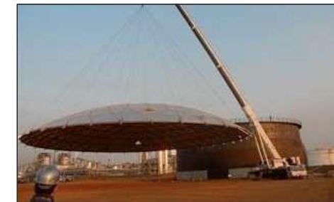
Monitoração de força em linga de várias pernas de cabo de aço.
