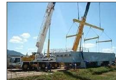
Içamento de aircooler com balancim (spreader bar) flutuante duplo e dois guindastes. Foto: União Engenharia.
