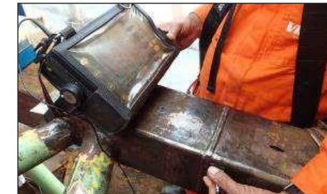
Fiscalização de execução de reparo em guindaste offshore
