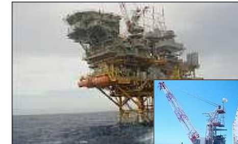
Inspeção em estruturas offshore
