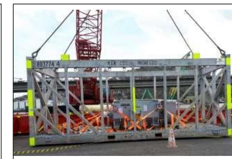
Projeto de lashing de motor em container
