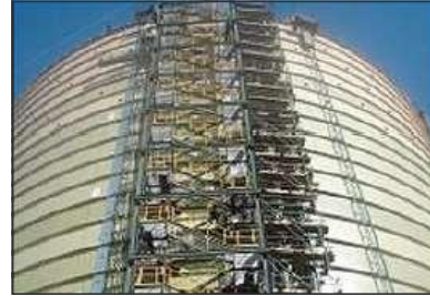
Engenharia de vários dispositivos de içamento e plataformas provisórias para montagem do gasômetro da CSA. Consultoria de estruturas metálicas para o teto em dômus do gasômetro. Foto: União Engenharia.
