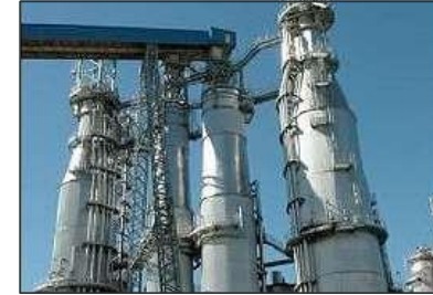
Projeto de içamento para plataformas provisórias para manutenção de digestor com 65 m de altura.
