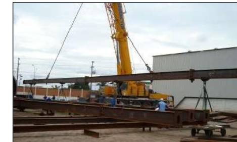
Teste de carga em spreader bar para lançamento submarino
