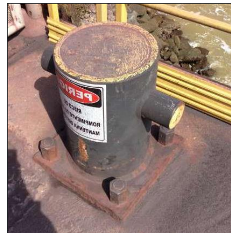
Teste de carga de até 500 t em equipamentos de amarração.
